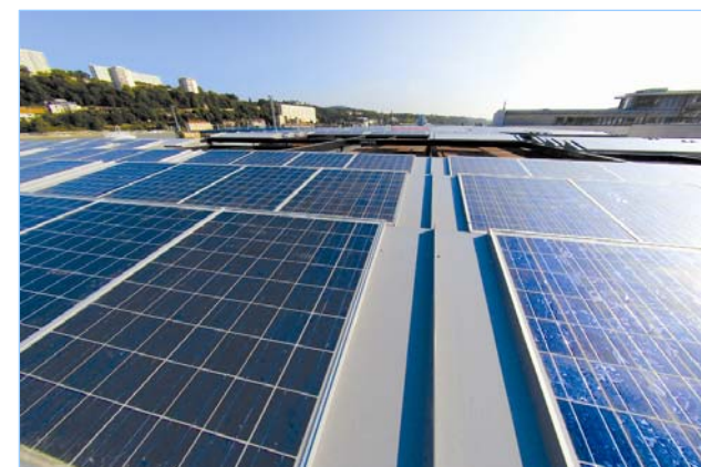
1 200 m 2 de panneaux photovoltaïques sur la toiture du parcs relais de Vaise.
