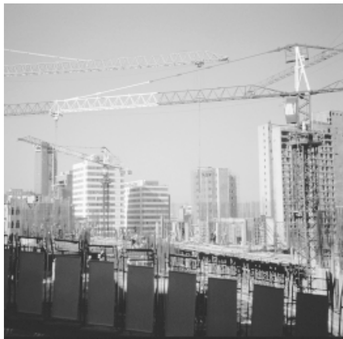
Chantier du centre ville - Beyrouth
